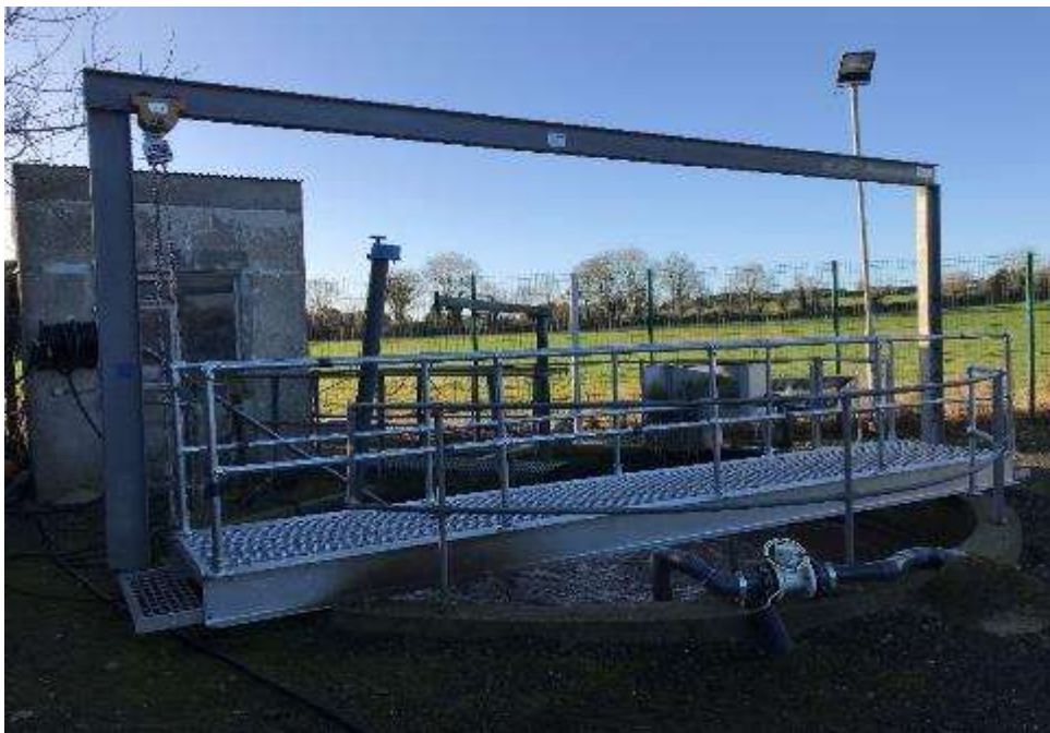
Córas Dhroichead Iompair & Ardaitheoir ag WWTP Thigh an Réileáin
