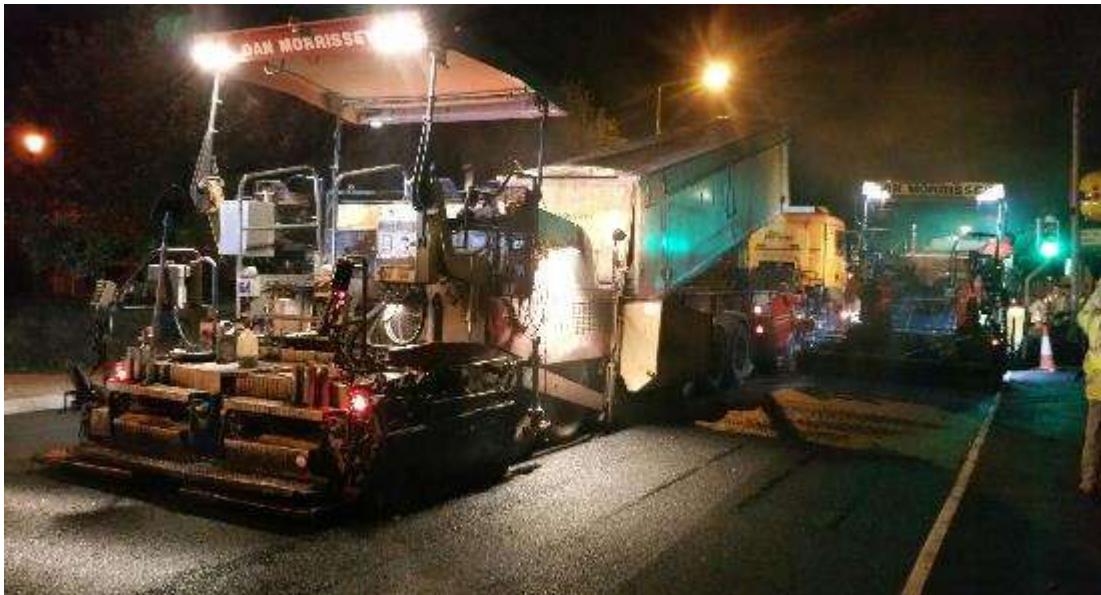
Oibreacha oíche ar an tionscadal N80, Bóthar na Tulaí, Baile Cheatharlach
